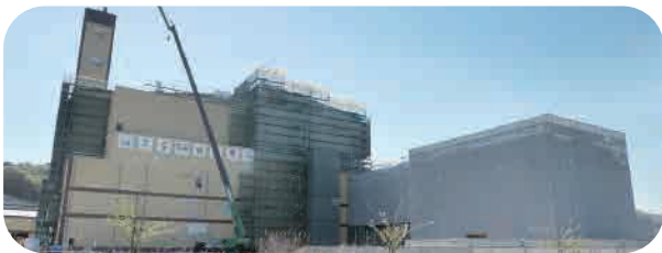
建設中の広域新ごみ処理施設
