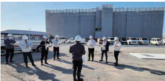
現地で地盤改良箇所などを確認
