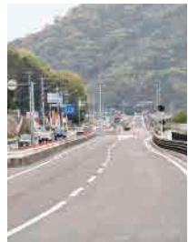
国道201号 4車線化工事
