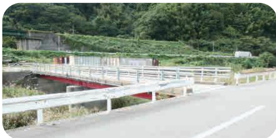
補修が完了した横尾橋
